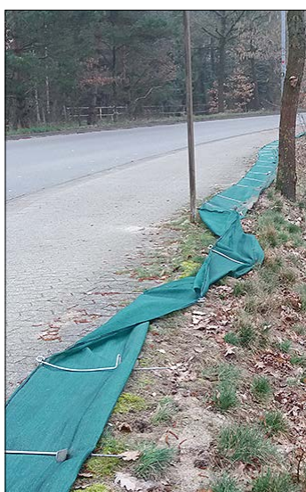
Der Amphibienschutzzaun wurde aus der Verankerung gerissen.
