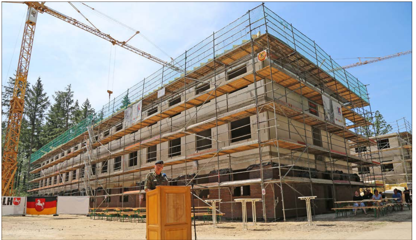
Die Redner, hier Brigadegeneral Olaf Rohde, begrüßten zahlreiche Gäste zum Richtfest in der Panzertruppschule. Dort entstehen am Ausbildungszentrum aktuell vier neue Unterkunftsgebäude.
