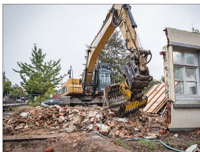
Die Abrissbirne schafft in der Harburger Straße Platz: Die Heidjers Stadtwerke bauen dort einen neuen Parkplatz und installieren zudem Stromtankstellen. Foto: Heidjers Stadtwerke
