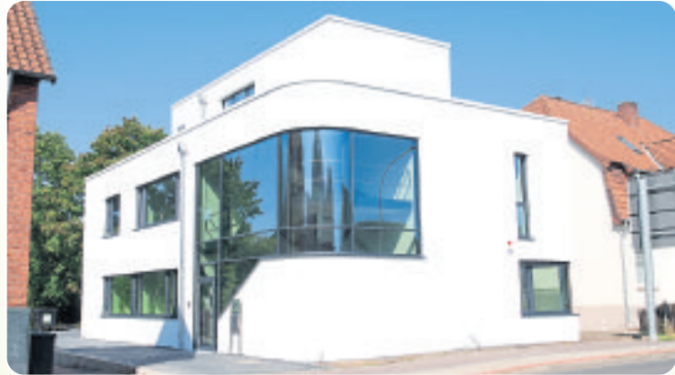
Prägnante Optik: das neue Praxisgebäude an der Winsener Straße 7.
