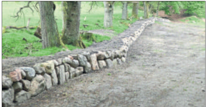
Mit diesen Steinen konnten sie bauen: Die sanierte Trockensteinmauer am Schlangengrund. Fotos: VNP-Stiftung Naturschutzpark Lüneburger Heide
