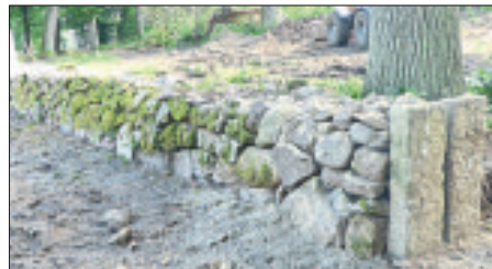
Die Trockensteinmauer am Hillmershof: Alt und neu gehen harmonische Verbindung ein.
