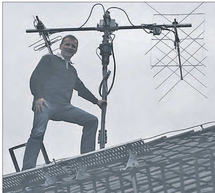
Die Antennen auf dem Dach des Soltauer Gymnasiums sind installiert und funktionieren. Markus Müller vom Walsroder DARC-Ortsverband ist zufrieden. Foto: mk
