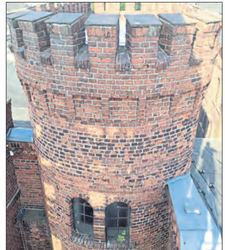
Der Treppen- und frühere Wasserturm der Soltauer Filzfabrik.
