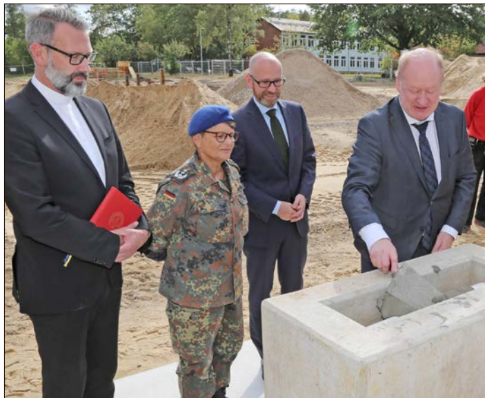
Grundsteinlegung für das neue Sanitätsunterstützungszentrum, ein Projekt mit einer Plansumme von knapp 19 Millionen Euro: (v.l.) Militärpfarrer Jürgen Stahlhut, Oberarzt Dr. Annette Frohse, Staatssekretär Peter Tauber und Finanzminister Reinhold Hilbers mauerten gemeinsam die Zeitkapsel ein.
