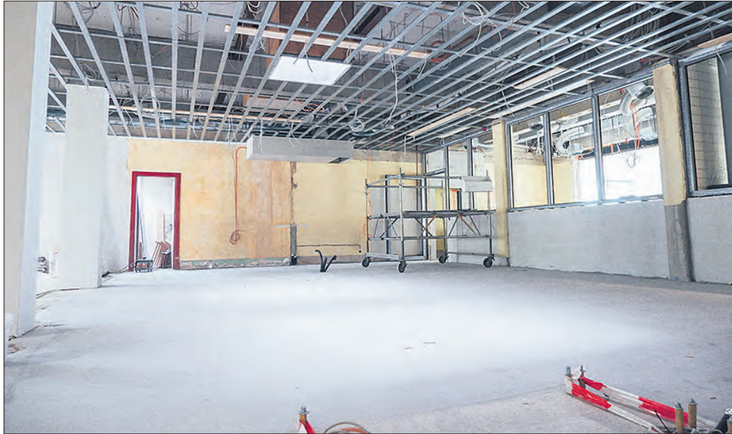
Noch gleicht der Eingangsbereich des Schneverdinger Bades Heidjers Wohl einer großen Baustelle. Unerwartete Probleme ziehen das Umbauprojekt in die Länge.
