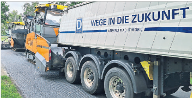
Asphalteinbau auf der K 6 zwischen Hützel und Evendorf: Bei der Sanierung der Kreisstraße kam ein hoher Anteil an recyceltem Material zum Einsatz. Foto: Landkreis Heidekreis
