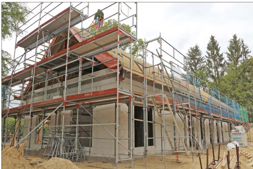
Gut gerüstet für die Zukunft: In der Schneverdinger Ortschaft Lünzen entsteht eine neue Kindertagesstätte. Am vergangenen Freitag stand das Richtfest auf dem Programm.
