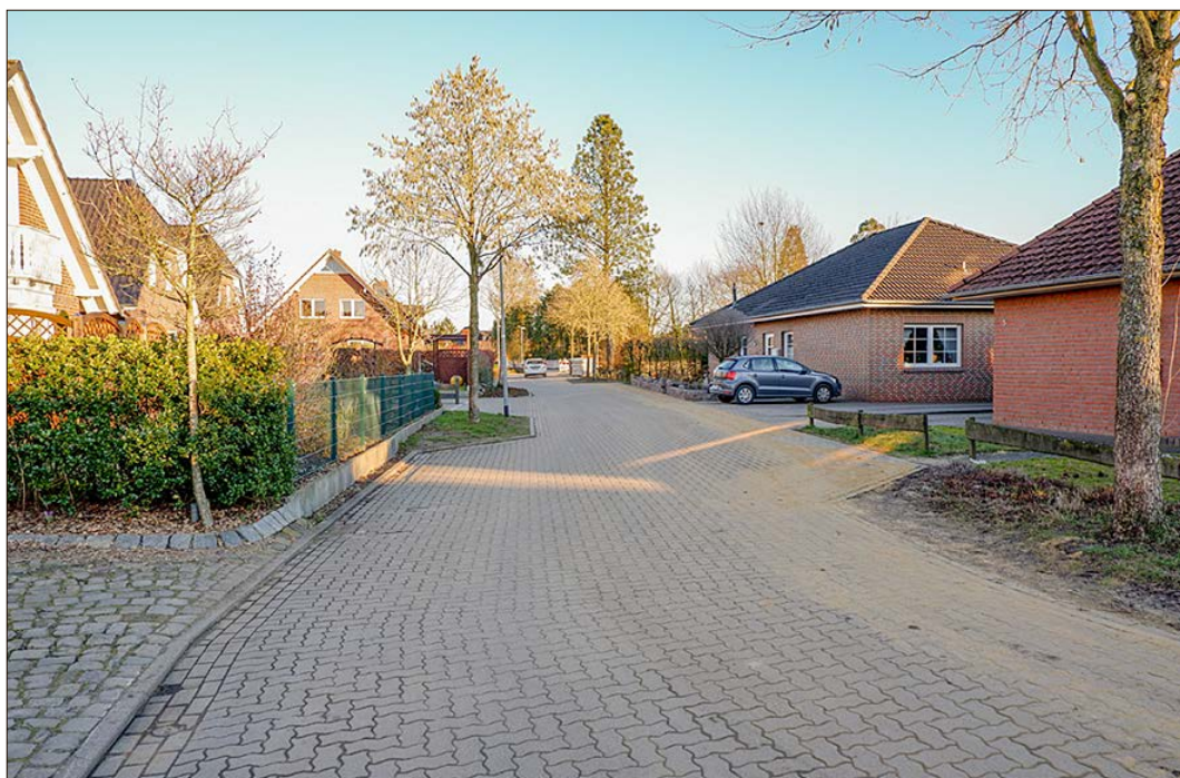
Strom für das Baugebiet Kuhlstücken: In Schneverdingen haben die Stadtwerke die Arbeiten in der Straße Im Haselbusch abgeschlossen.
