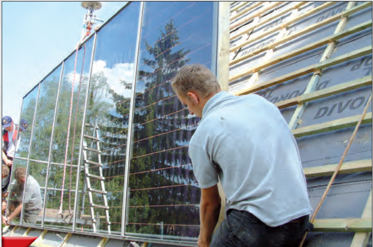
Aus dem Schieferdecker des 12. Jahrhunderts ist heute der Hightech-Handwerker Dachdecker geworden. Werkfoto: DVNr.
