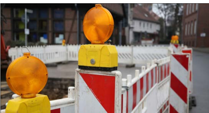
Die Oberflächen mehrerer Soltauer Straßen werden in den nächsten Monaten durch die AWS saniert. Foto: Archiv
