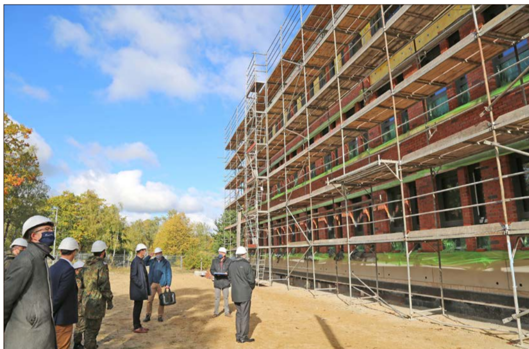
Männer, die auf Ziegel starren: Vertreter von Bundeswehr, Politik und Staatlichem Baumanagement machten sich bei der Begehung ein Bild vom neuen Komplex, der mit roten Steinen verblendet wird. Fotos: suv
