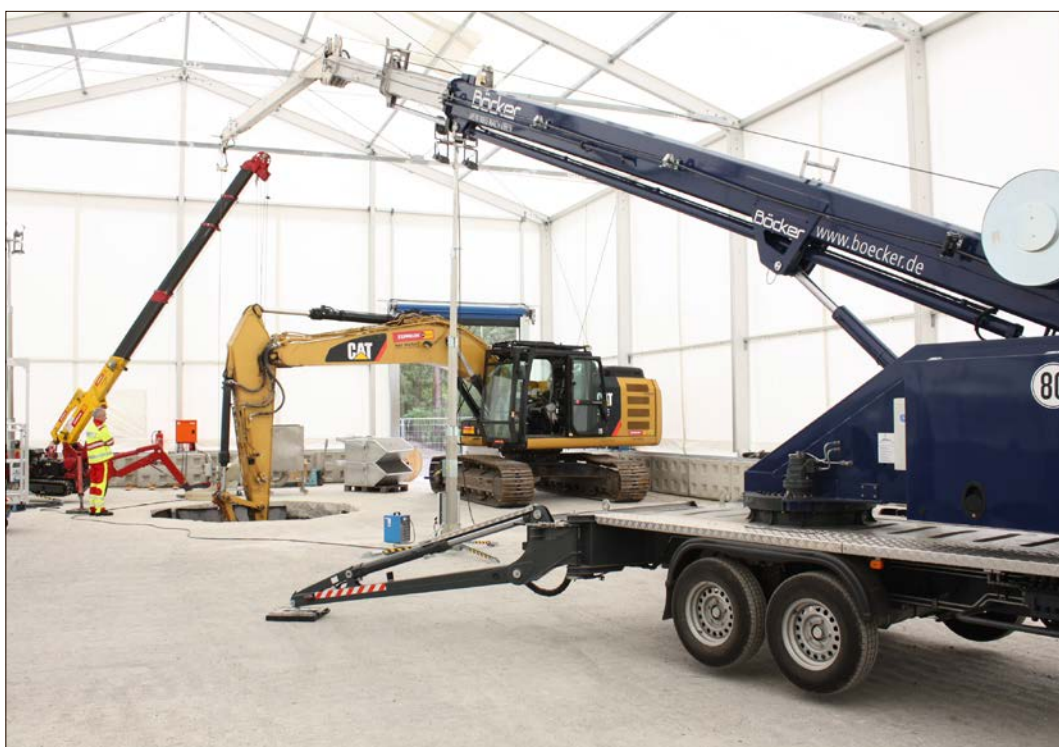
Kräne und Bagger sind bereits im Zelt auf dem Dethlinger Teich positioniert, wo jetzt die Arbeiten zur Öffnung beginnen.
