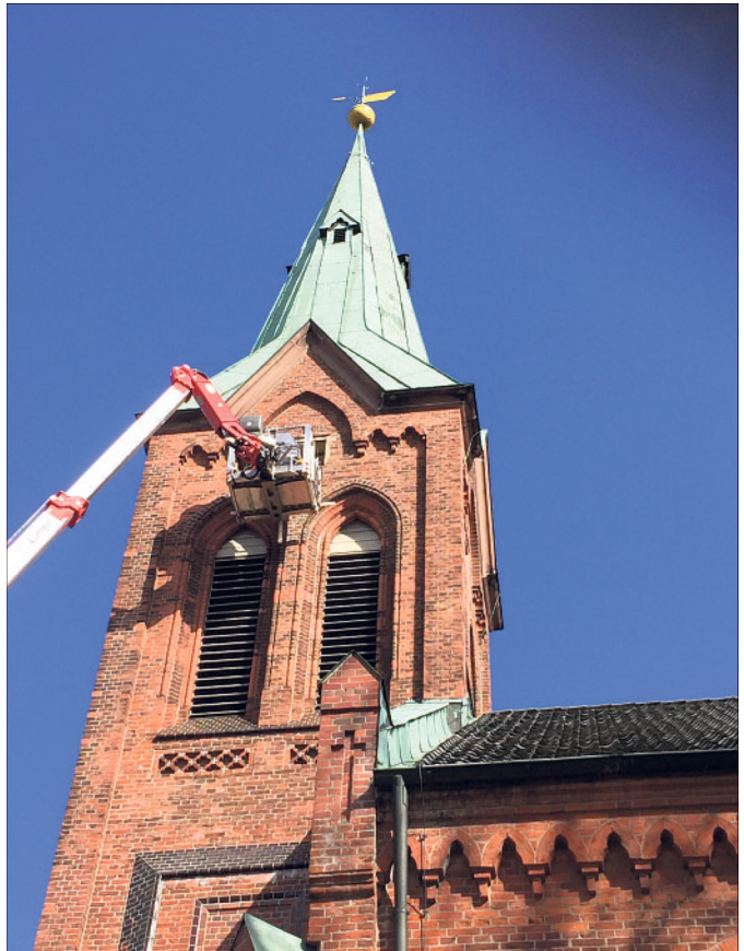
Montage in luftiger Höhe: 22 Meter über dem Boden setzten die Teams die restaurierten Zifferblätter am Turm von St. Bartholomäus in Neuenkirchen ein.
