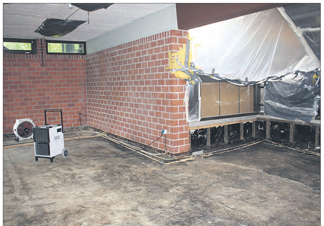
Wo sich eigentlich die Kinder- und Jugendbibliothek der Waldmühle befindet, sieht es derzeit öde aus. Ventilatoren sollen die Trocknung nach dem Wasserschaden beschleunigen. Fotos: mwi
