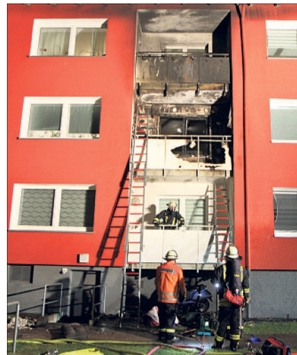
Zu einem Brand nach einer Explosion in einem Mehrfamilienhaus in der Straße Klappgarten rückten die Feuerwehren Munster, Breloh und Ilster-Alvern-Töpingen am vergangenen Samstag mitten in der Nacht aus.
