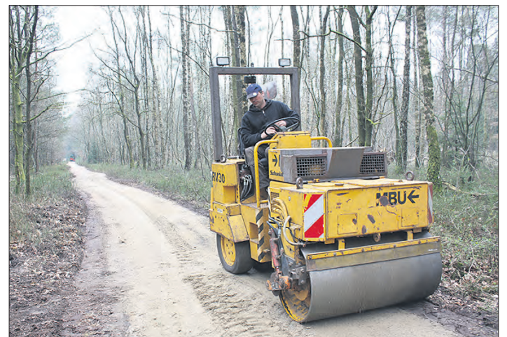
Mit schwerem Gerät bereitet ein Arbeiter den Weg vor, damit das Mineralgemisch aufgebracht werden kann.
