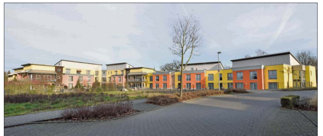
Rund ein Jahr haben die Bauarbeiten für Erweiterung der Wiesentritt gedauert.
