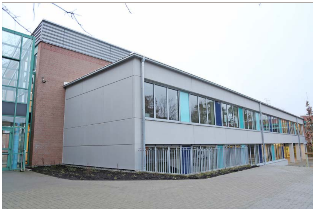
An den alten C-Trakt (Backstein) wurde ein Anbau angesetzt. Der neue Gebäudeteil (grau) brachte acht zusätzliche Unterrichtsräume.
