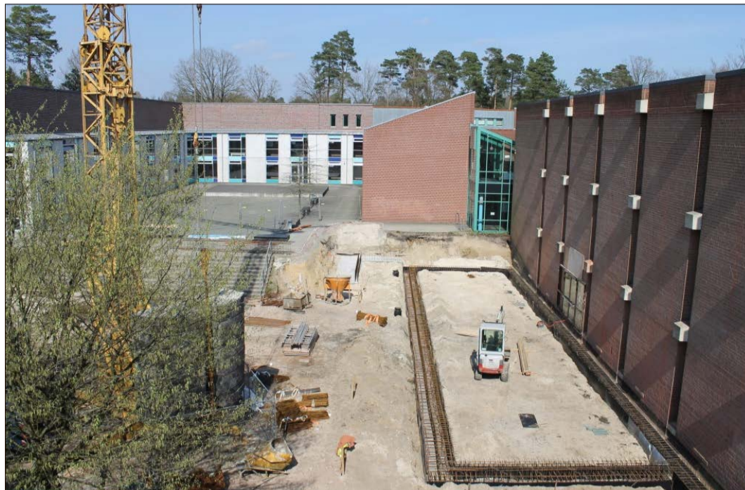
Schulhof als Baustelle: Dort entstand der Anbau an den C-Trakt.
