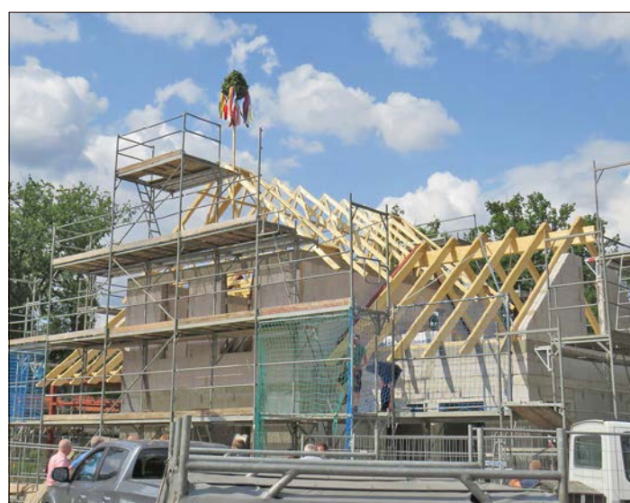
Richtfest: Der Bau des Tourismuspavillons in Bispingen macht große Fortschritte.
