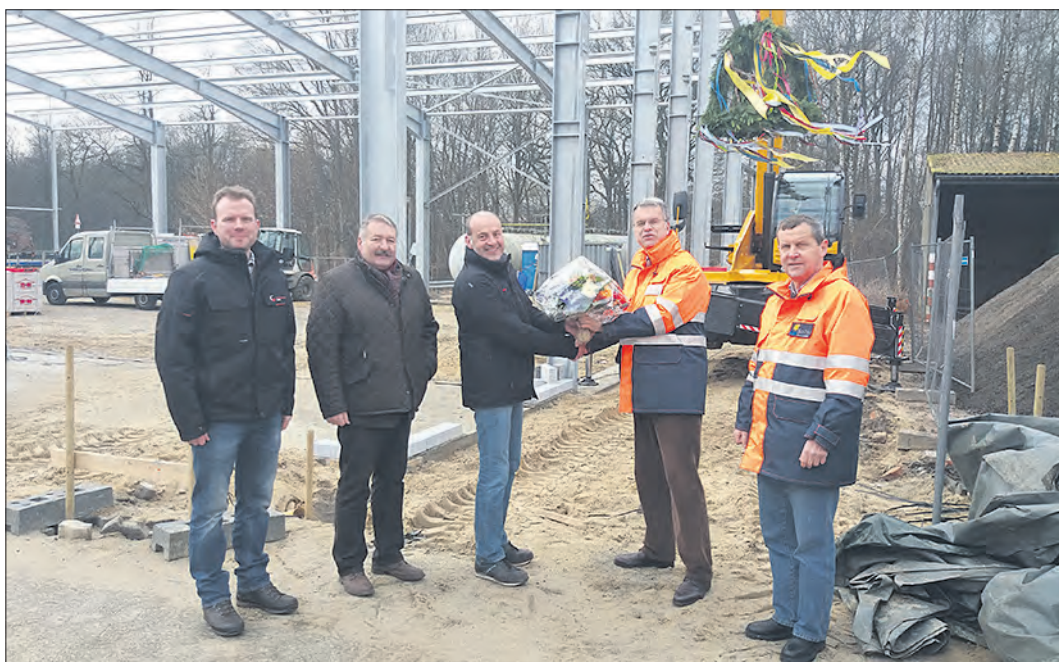
Richtfest der neuen Lagerhalle konnten die Stadtwerke Soltau am vergangenen Freitag feiern.
