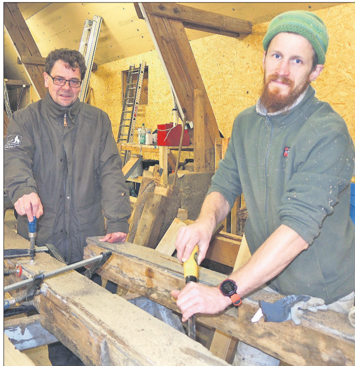
Zimmerer Benjamin Leinecker (vorne) restauriert in der Werkhalle in Niederhaverbeck die historischen Balken. VNP-Fachbereichsleiter Steffen Albers freut sich über den Fortschritt der Arbeiten.
