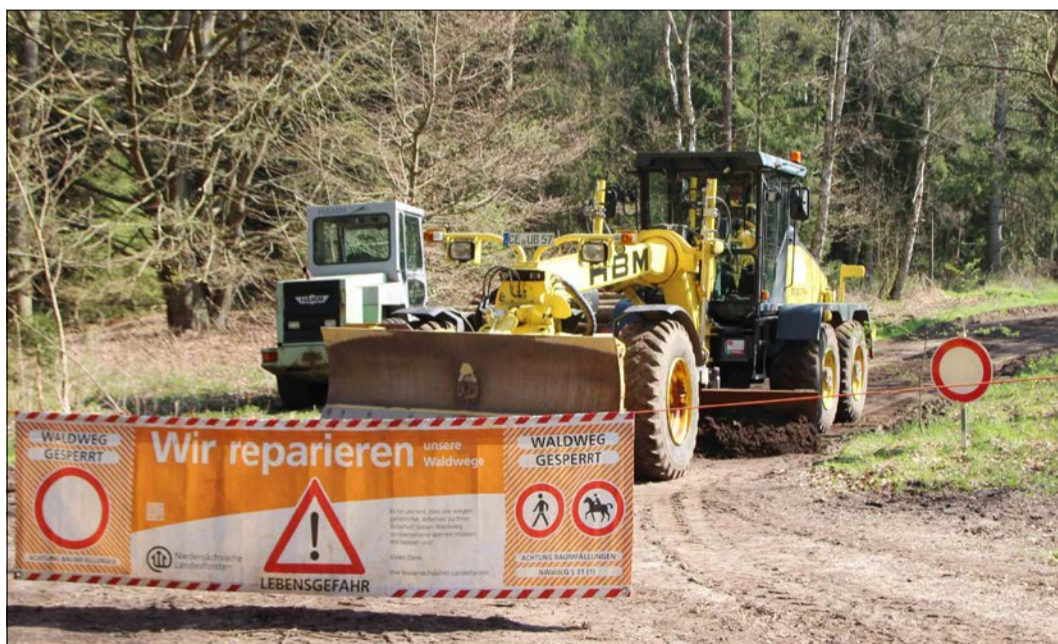
Sanierung der „Rennbahn“ im Naturschutzgebiet Lüneburger Heide: Während der Bauarbeiten werden Wege gesperrt.
