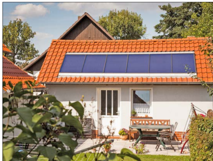
Insbesondere Photovoltaik erfreut sich einer steigenden Beliebtheit. Ein „Solar-Check“ zeigt Ihnen, welche Möglichkeiten für eine Solarenergienutzung Sie haben. Foto: Solvis
