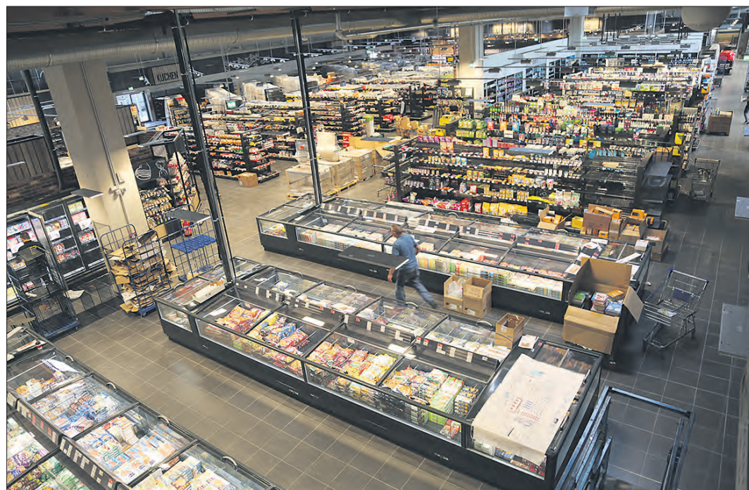
Blick von der Hebebühne eines Handwerkers in einen Teil des neuen E-Centers.
