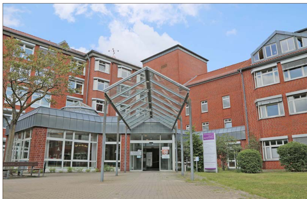
Die Planungen für ein neues HKK - hier das Soltauer Haus - gehen offensichtlich voran.
