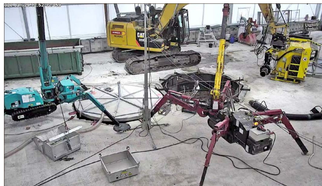
Das Foto zeigt in der Bildmitte den verschlossenen Schacht 1 und daneben den geöffneten Schacht 2. Der Bagger kann beide Schächte bedienen.
