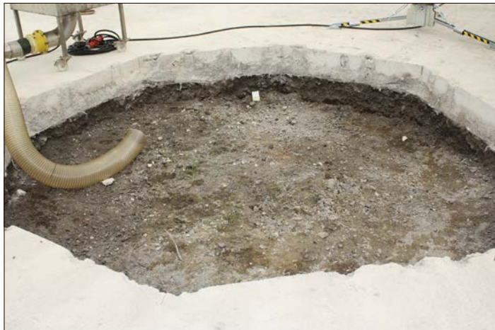
In der Bodenplatte des Zeltes ist bereits der „Zugang“ zum Dethlinger Teich angelegt worden. Fotos: mwi
