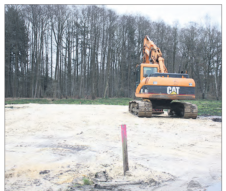
Im Bereich „Wohngebiet östlich der Moorstraße“ sind die Erschließungsarbeiten ange laufen.
