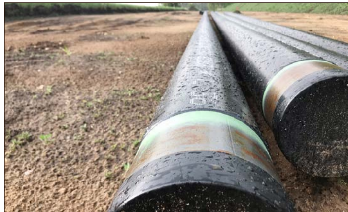
Die Stadtwerke Munster arbeiten am Anschluß an das Fernleitungsnetz mit dem Bau der neuen Gashochdruckleitung zwischen Oberohe, Poitzen und Munster. Foto: Stadtwerke Munster
