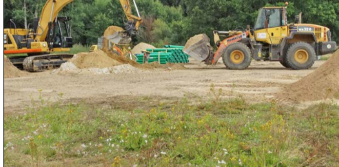
Die Bagger sind vor Ort - die Erschließung von „Am Allermoor“ hat begonnen. Foto: Gemeinde Bispingen
