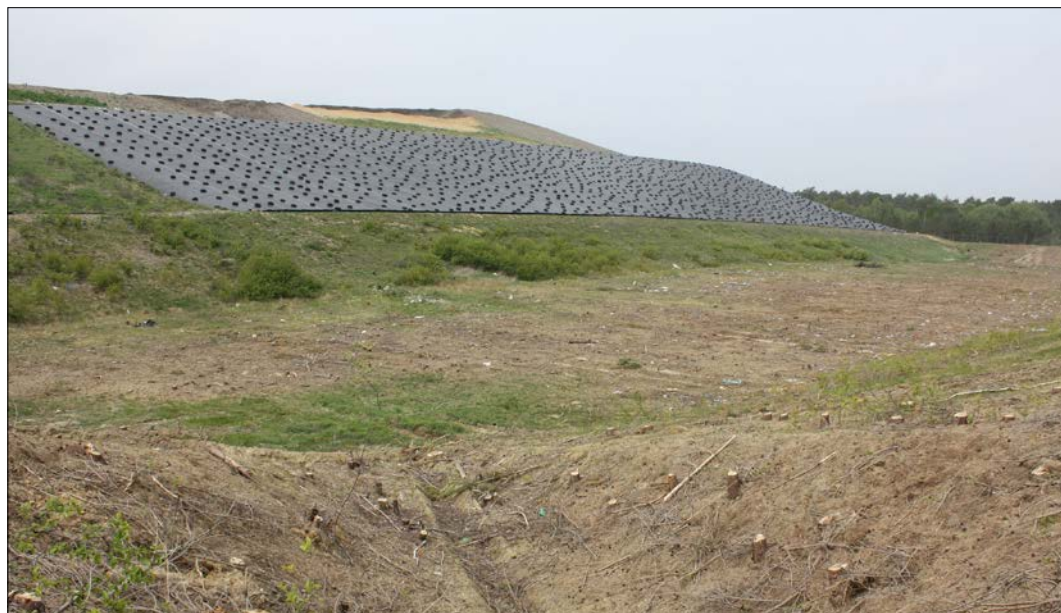
Die Mülldeponie Hillern: Im Vordergrund der Bereich des Bauabschnitts 5, in dem ab kommenden Jahr mineralischer Abfall gelagert werden soll.
