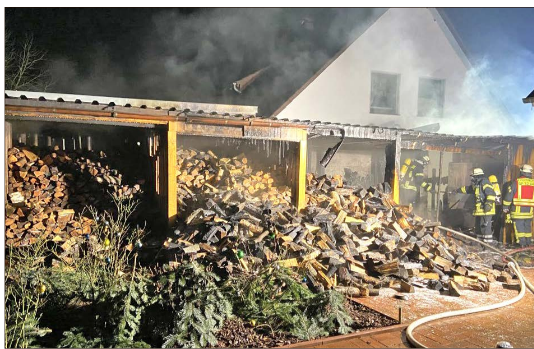
Zu Beginn des neuen Jahres brannte in Soltau ein an eine Garage angebautes Schuppen in voller Ausdehnung. Die Feuerwehren Soltau und Wolterdingen konnten das Schlimmste verhindern.
