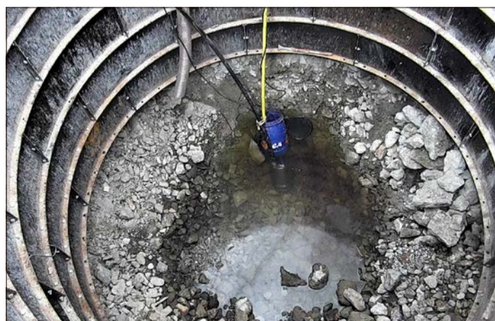
Erkundungsarbeiten am Dethlinger Teich: Die Grundwasserfläche ist im Schacht 1 freigelegt. Auch an Schacht 2 kann nicht mehr gearbeitet werden. Jetzt wird ein dritter Schacht erstellt. Foto: Landkreis Heidekreis
