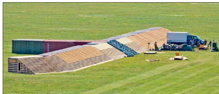
Sturmfest und erdverwachsen: Ein 100 Meter langer Deich entsteht auf dem Fliegerhorst Faßberg.
