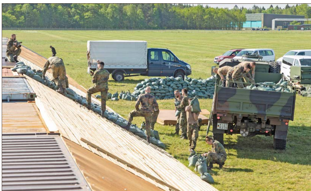
Errichtung des Deiches auf dem Fliegerhorst in Faßberg: Soldaten und Soldatinnen des Transporthubschrauberregiments 10 „Lüneburger Heide“ befüllen und stapeln Sandsäcke für die Vorführung am Tag der Bundeswehr.
