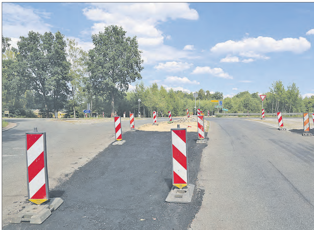
An der A-7-Anschlußstelle Dorfmark wird derzeit ein Kreisverkehrsplatz gebaut.
