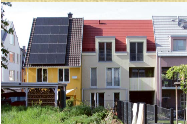
Eine Solaranlage kann den Energieverbrauch im Haus senken. Werkfoto: Zweigler/be.p
